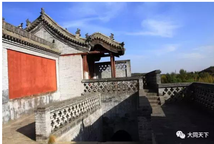
前院有一座戲臺，建造於離地 8 米高的券洞口上。 24
